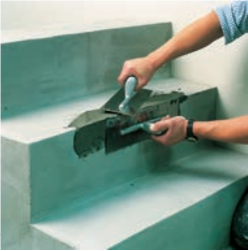
ARDEX A 45 ile merdiven tamirati yapılması.
