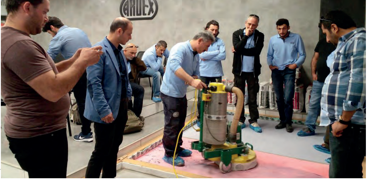
Yüzeyin kuruma sonrası 24 saat içinde zımparalanması.
