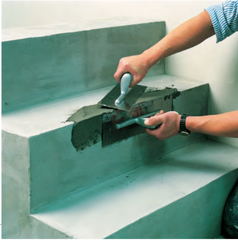
ARDEX A 45 ile merdiven tamirati yapılması.
