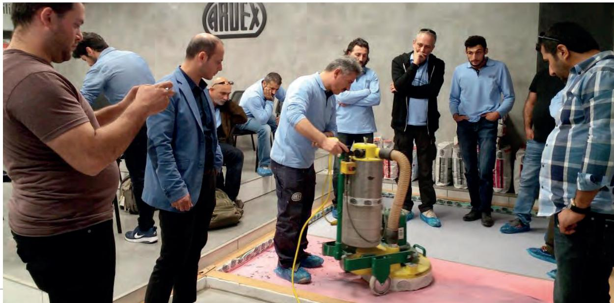
Yüzeyin kuruma sonrası 24 saat içinde zımparalanması.
