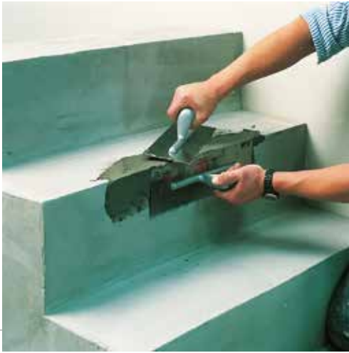
ARDEX A 45 ile merdiven tamirati yapılması.
