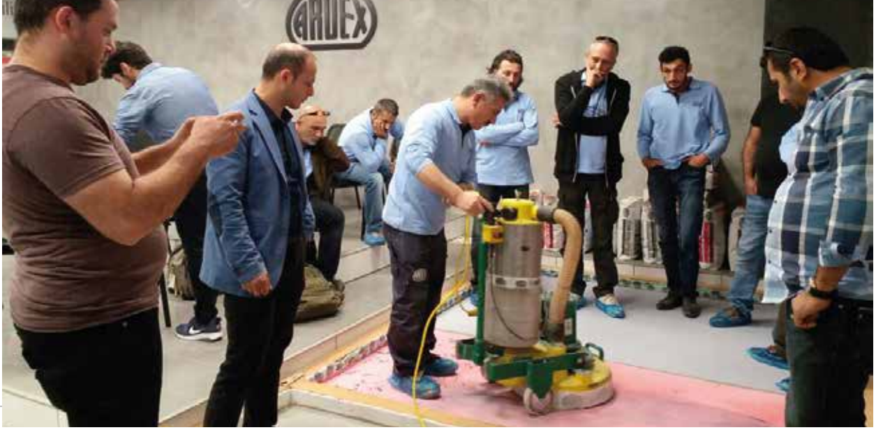
Yüzeyin kuruma sonrası 24 saat içinde zımparalanması.
