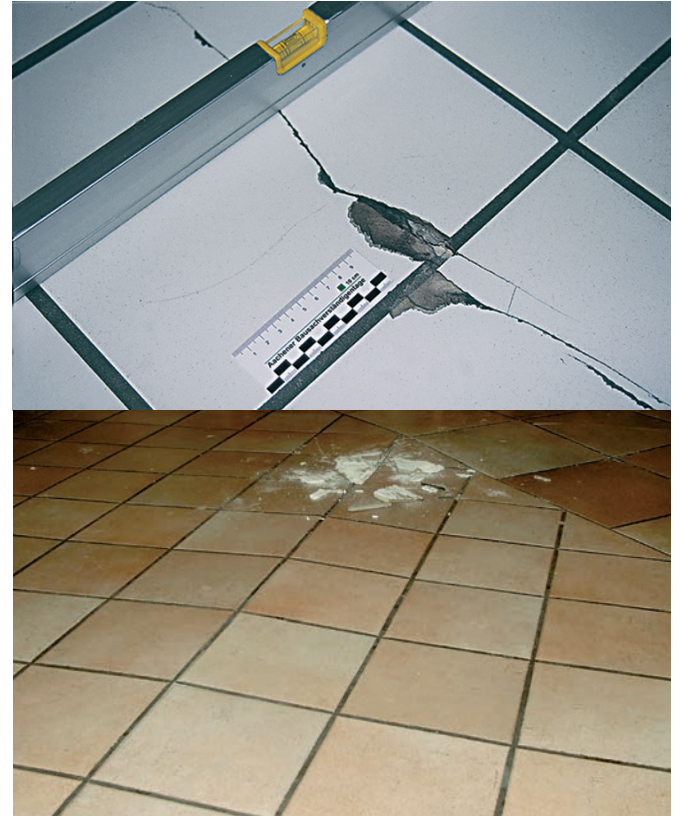
Zeminin içinde oluşan genişleme gerilmeleri kaplamaların farklı genişleme katsayısına göre değişiklik gösterir.
