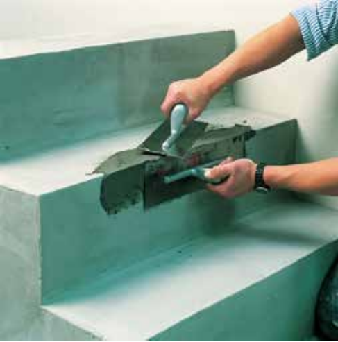
ARDEX A 45 ile merdiven tamirati yapılması.
